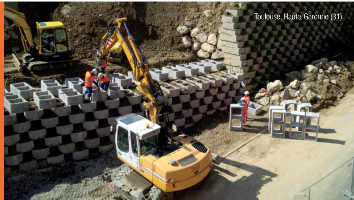
« La solution Reboul® a également permis de **limiter les travaux de pose et de remplissage des caissons** qui a d'ailleurs nécessité peu de moyens en termes d'exécution et de manutention. »
